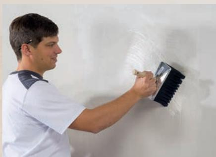
Utilizzare un rullo appropriato per l'applicazione dell'adesivo per polistirolo espanso diluito (aggiungere il 20% di acqua) e lasciare asciugare prima di ulteriori lavorazioni.
